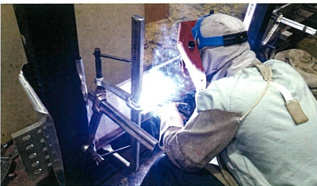
アルミブスバー溶接
